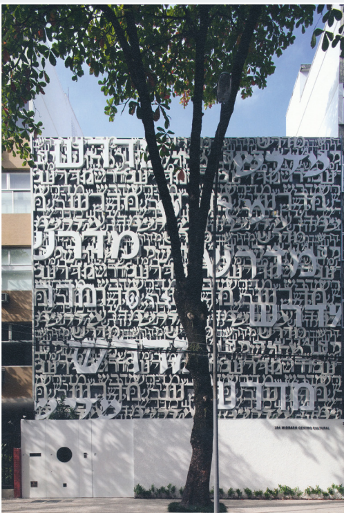
Midrash Cultural Center Rio de Janeiro, Brasilien 2009 (Architekt: Isay Weinfeld), Foto: Leonardo Finotti.
